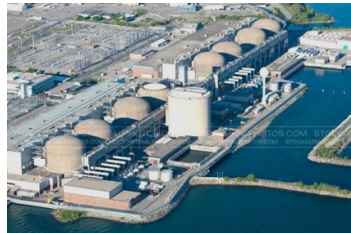
カナダ ピッカリング発電所 (Hydro-Québec)
