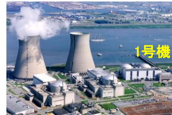
ベルギー ドール発電所 (from Electrabel)
