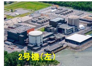
カナダ ジェンティイ発電所 (Hydro-Québec)
